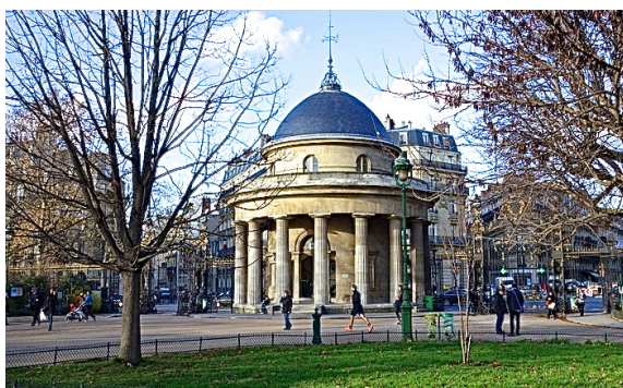
La Rotonde du Parc Monceau qui faisait partie d'un des pavillons d'octroi subsistants de l'enceinte des Fermiers généraux édifiés par Claude-Nicolas Ledoux (1736 - 1806).
