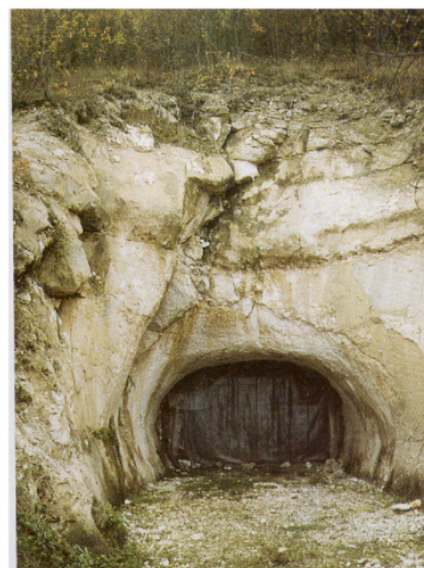
Anciennes carrières souterraines : Les Caves de la Mignonne. A gauche : Etat actuel A droite : Avant aménagement, la fracture à gauche de l'entrée est en relation avec la Faille de Sancerre.
