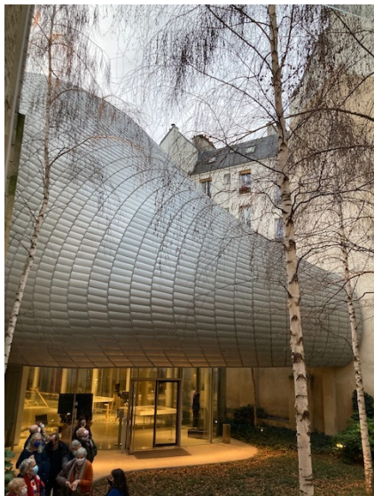
Entrée jardin, coque et verrière.
